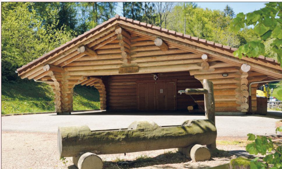
Le refuge du Trésy II construit en 2001.
