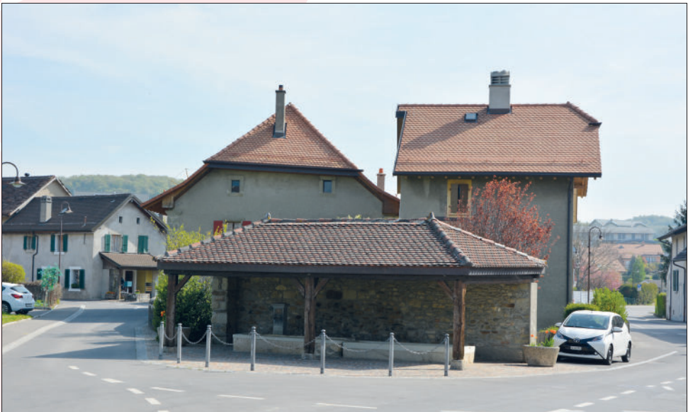
La fontaine couverte réaménagée en 2006 (construction en 1822).
